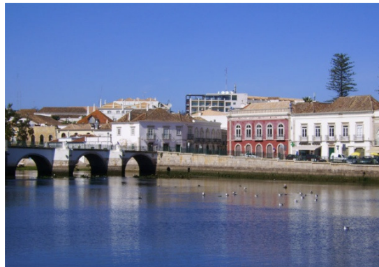
Fig. 1 - Vista geral da margem esquerda do Rio Gilão, Tavira (Foto de autoria do Eng.º José Mattos e Silva)
